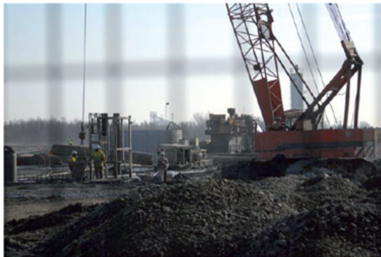
Décembre 2006, le chantier avance à grand pas pendant que la démocratie recule...
